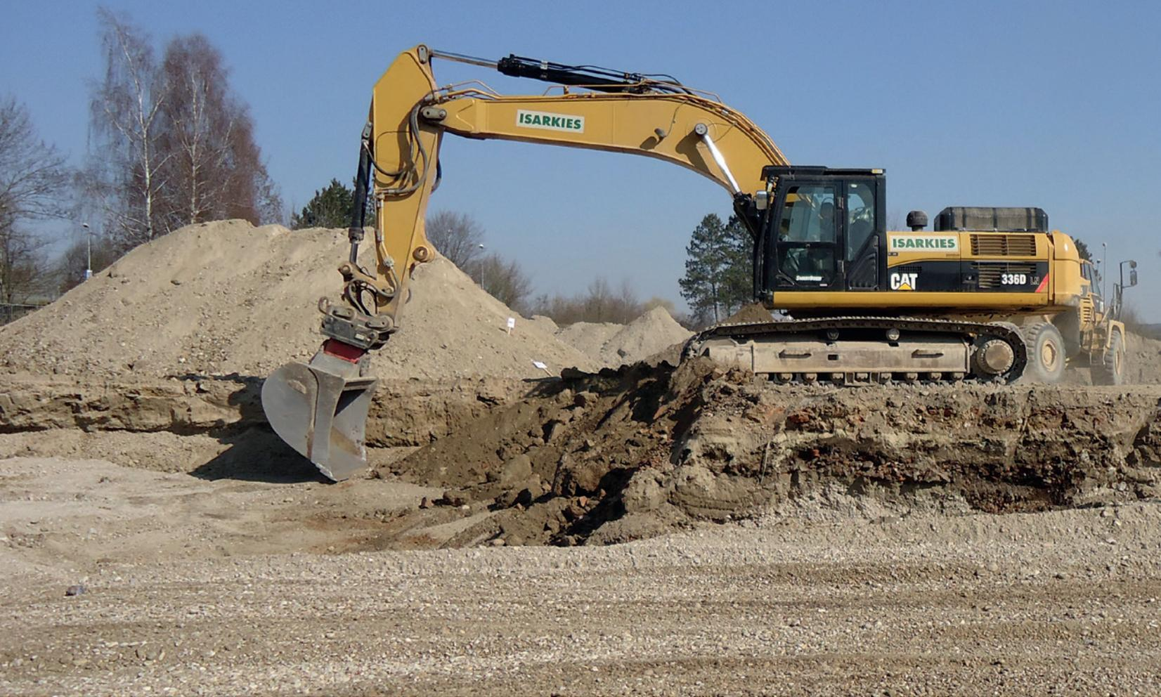
Abhängig von der vorherigen Nutzung des Geländes ist nach dem Rückbau von Gebäuden oft eine Altlastensanierung des Untergrundes notwendig. Belastetes Erdreich wird dabei ausgehoben, analysiert und entsprechend
